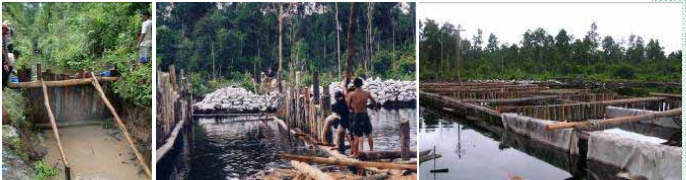
Penyekatan saluran air ( canal blocking ) untuk menjaga ketersediaan air dan menghindari terkurasnya air pada lahan gambut
